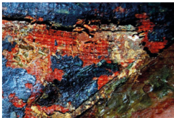
28. Zatečeni detalj oštećenja slike sa svoda oltarne kompozicije (snimila Ž. Matulić Bilač, 2007.)
