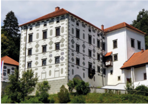
13. Rogatec, dvorac Strmol, pročelja (snimila N. Vasić, 2015.) Rogatec, Strmol Castle, façade (photo by N. Vasić, 2015)
