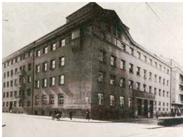
20 Ugao Ulice kralja Zvonimira 8 i Antuna Bauera 32 1930-ih, Ekonomska visoka škola (Prirodoslovno-matematički fakultet). Zgrada je građena prema projektu Vjekoslava (Alojza) Bastla 1927./8. U pozadini se vidi Bastlova stambena zgrade Ekonomske visoke škole u Bauerovoj ulici 34
