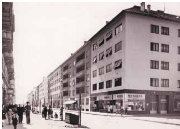
23 Pogled na Bauerovu ulicu uoči Drugog svjetskog rata. U prvom planu vidi se zgrada Janović-Šerka na uglu Bauerove ulice 10 i Martićeve ulice 14f. Zgrada je izgrađena 1937./8. prema projektu Antuna Ulricha. (Foto Tošo Dabac, Uprava za zaštitu kulturne baštine)
