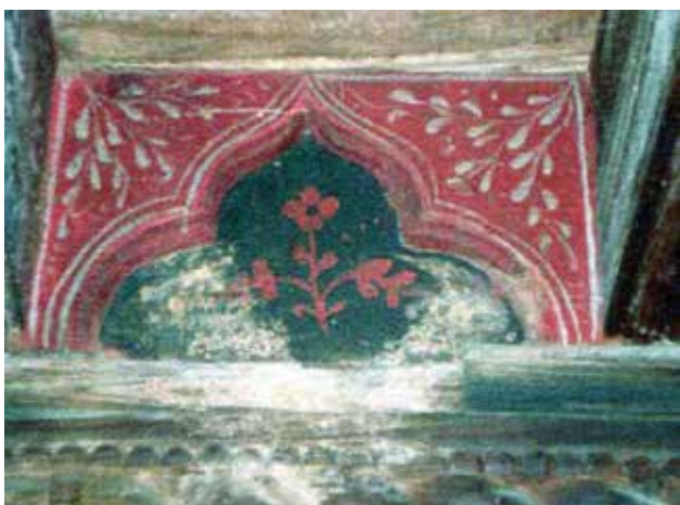
9 Čiovo, drvena konstrukcija kapitularne dvorane, detalj zaglavne ploče (foto: A. Gamulin, 2006.)
