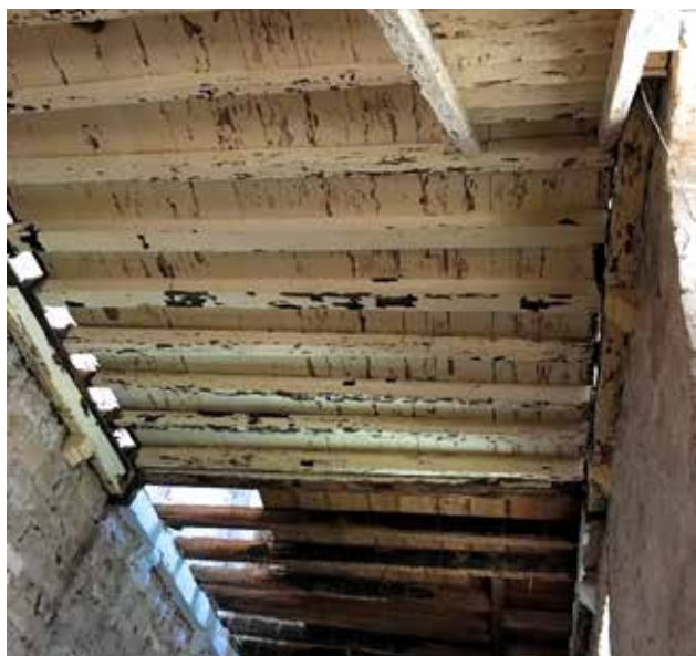
33 Zatečeno stanje grednjaka prije demontaže (foto: G. Sava', 2015.) Current condition of architrave prior to dismantling (photo: G. Sava', 2015)
