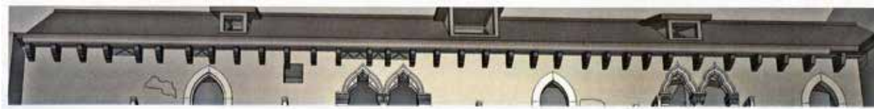
14 Izgled strehe na južnom pročelju (dokumentacija: restaurator G. Sava, 2015.)
