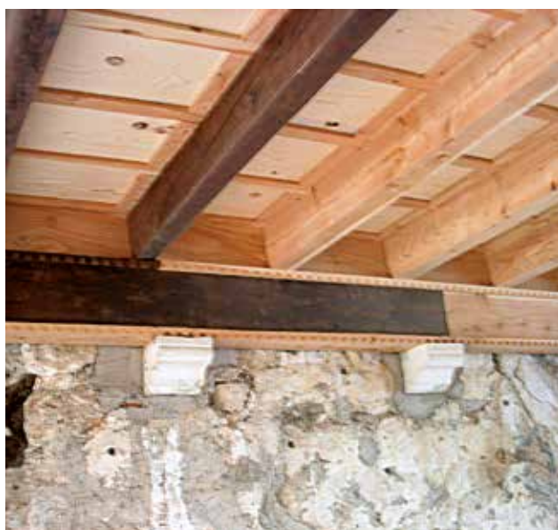
31 Gotička tavanica tijekom montaže (foto: Anita Gamulin, 2005.) Gothic plafond during installation (photo: Anita Gamulin, 2005)
