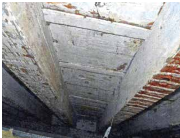
40 Stanje konstrukcije nad prvim katom (foto: G. Sava' 2010.)
