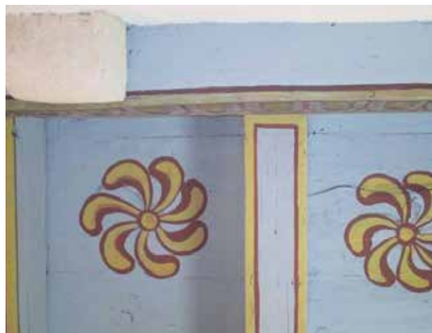
38 Detalj oslika greda i daščanog poda, pogled na strop (foto: G. Sava, 2000.)
