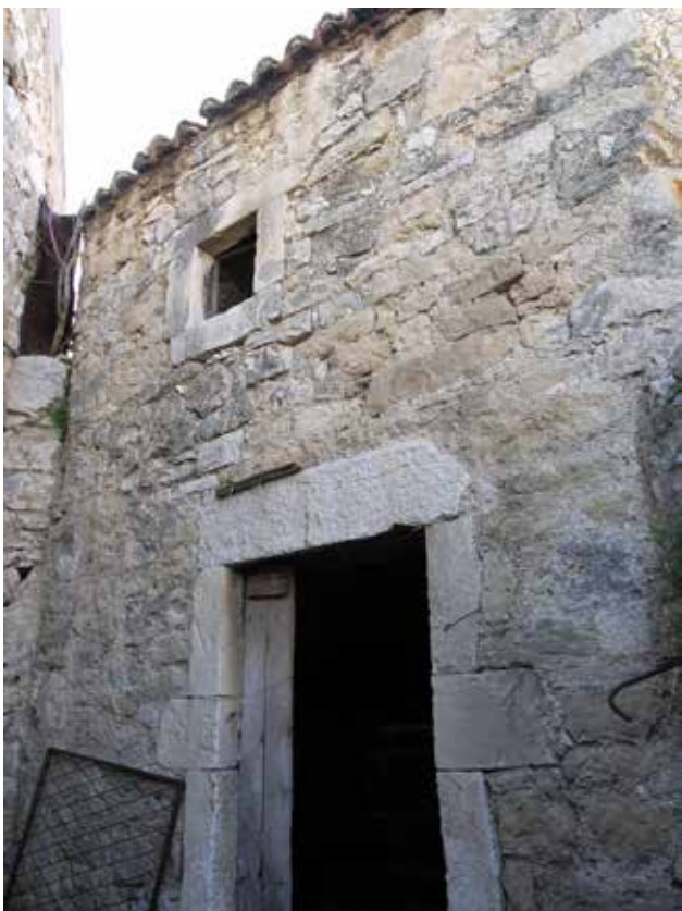
7 Pogled na sjeveroistočni dio polukružne kule s glavnim ulazom (foto: Ž. Stošić)
