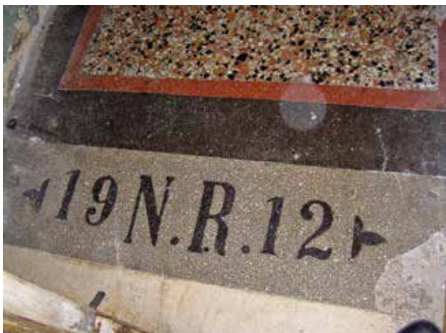
10 Kuća na k. č. 5918/1, pod od brušenog teraca iz 1912., današnje stanje (foto: I. Šprljan)
