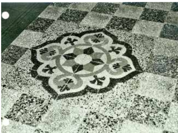
11 Pod od teraco pločica u sakristiji crkve sv. Lovre, stanje 1998. (foto: I. Šprljan)
