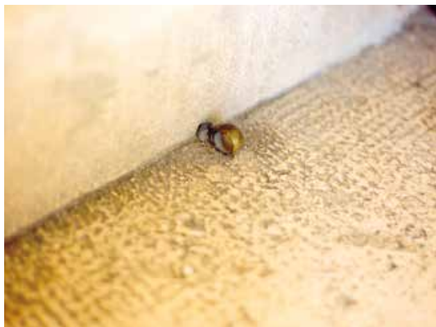
33 Mjedeni držač za tepih na stubištu kuće na k. č. 5867, stanje 2000. (foto: I. Šprljan)
