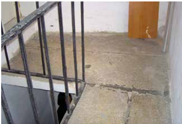
22 Palača Divnić, stubište, stanje 2016. (foto: I. Šprljan) Divnić Palace, stairwell, state in 2016 (photo: I. Šprljan)
