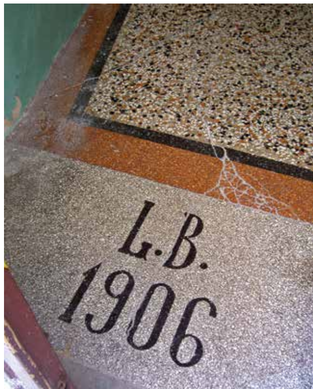
9 Kuća na k. č. 5912, pod od brušenog teraca iz 1906., današnje stanje (foto: I. Šprljan) House on cadastre lot 5912, polished terrazzo floor from 1906, present state (photo: I. Šprljan)
