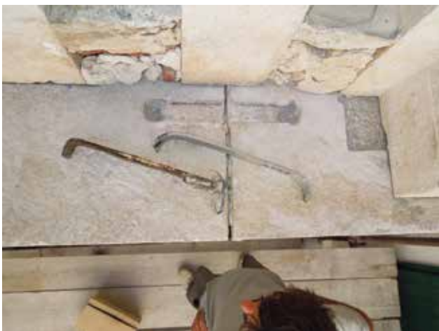
20 Zamjena starih, korodiranih klamfi novima od nehrđajućeg čelika (foto: S. Pranjić) Replacement of old, corroded cramps with new stainless steel ones (photo: S. Pranjić)
