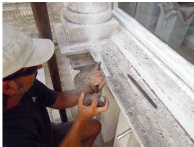
25 Priprema kamena za tašeliranje „u suho“ (foto: S. Pranjić) Preparation of stone for patching „in the dry“ (photo: S. Pranjić)
