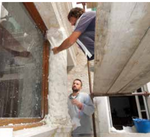
23 Odsoljavanje kamenih stupova pomoću papirnate pulpe natopljene destiliranom vodom (foto: S. Pranjić) Desalinisation of stone pillars with paper pulp soaked in distilled water (photo: S. Pranjić)
