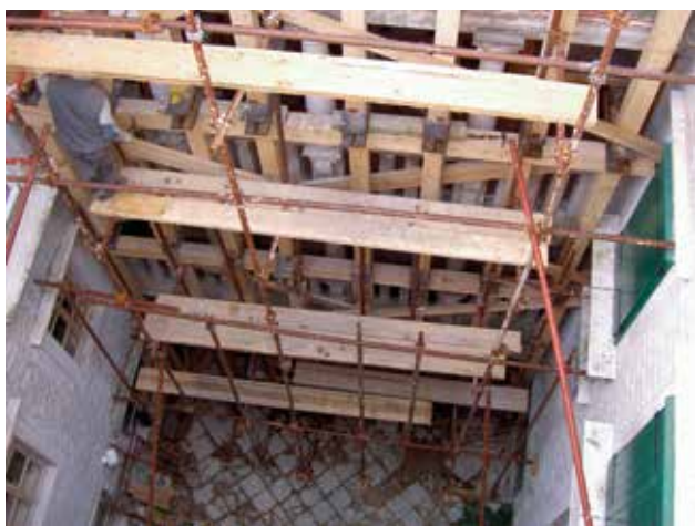
11 Pogled na vanjsku skelu (foto: I. Šprljan) View of outer scaffold (photo: I. Šprljan)
