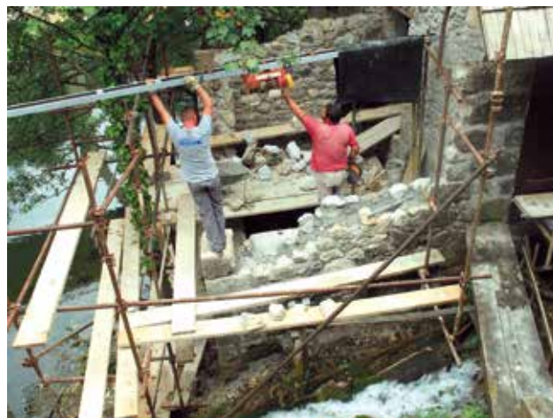
19 Izvlačenje i ugradnja originalnih klesanaca – rujan 2015 ( foto: S. Jakšić) Extraction and installation of original cut stones – September 2015 (photo: S. Jakšić)
