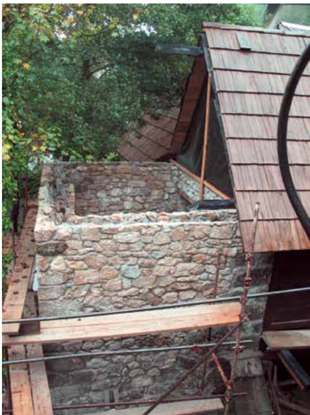
20 Završetak kamenarskih i zidarskih radova – sredina listopada 2015. (foto: S. Jakšić)
