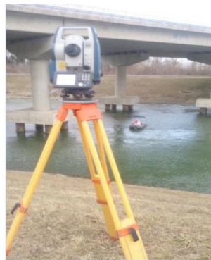
Slika 3. Primjena hibridnog sustava pozicioniranja i dubinomjera pri snimanju poprečnih profila ispod mosta
