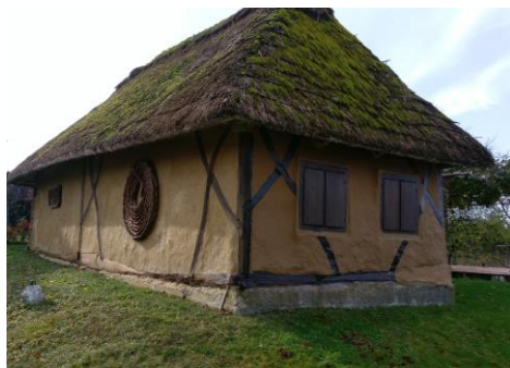
Slika 1. Međimurska hiža –obnovljena; namjena: kuća za odmor
