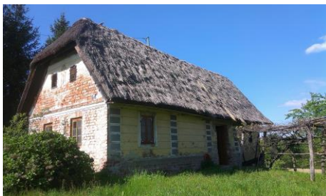
Slika 4. „Međimurska hiža“ - postojeće stanje
