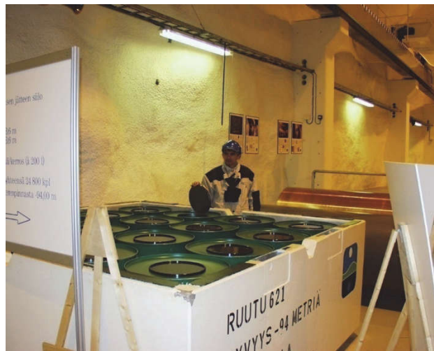
Slika 1. Kontejner s metalnim dvjestolitarskim bačvama za pakiranje RAO u odlagalištu Olkiluoto u Finskoj.
