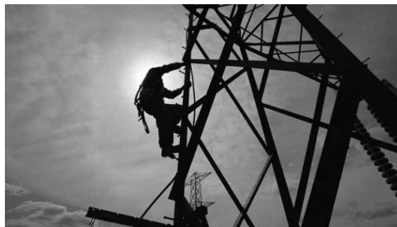
Slika 4. Radnik na stupu dalekovoda
