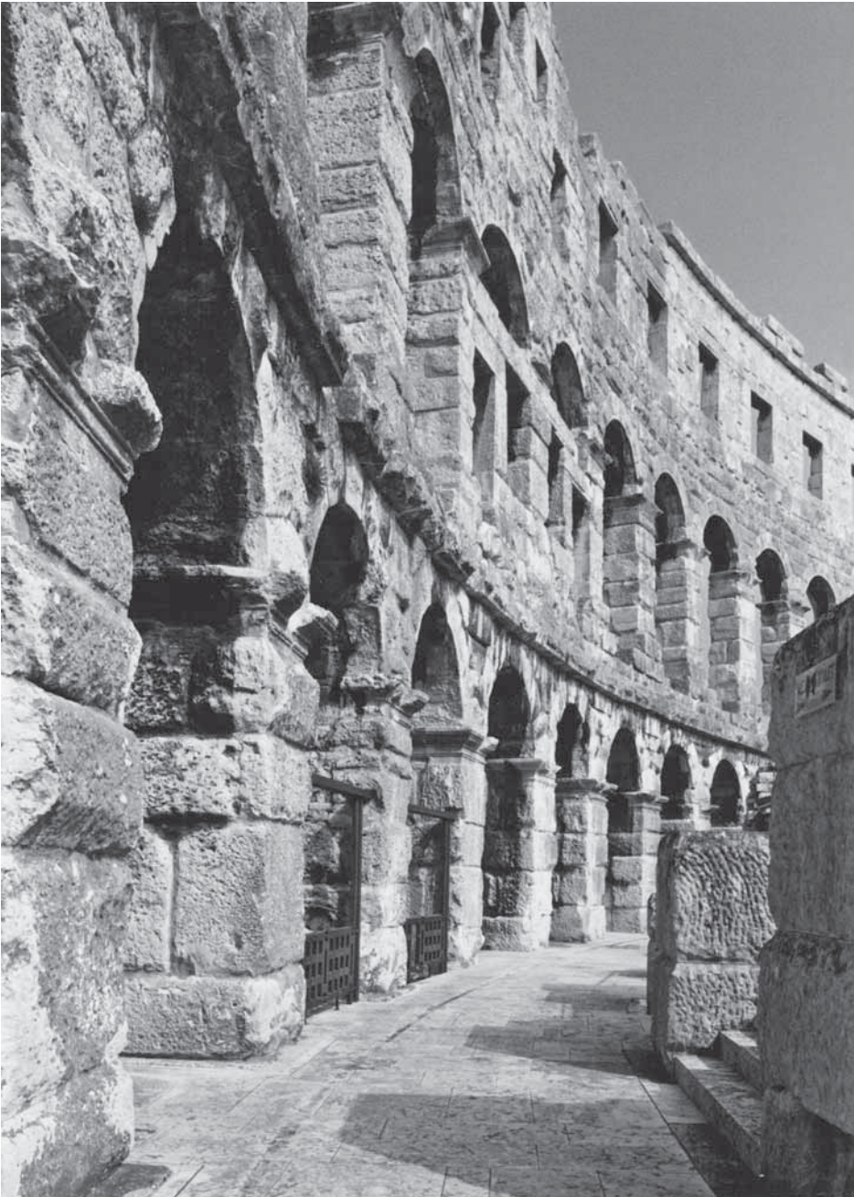
SL. 1. PRVI CIRKULARNI HODNIK, JUGOZAPADNI DIO NAKON REKONSTRUKCIJE FIG. 1 FIRST CIRCULAR PASSAGEWAY, SOUTHWESTERN PART AFTER RECONSTRUCTION
