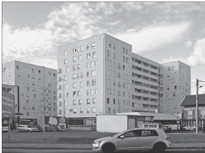
SL. 4. PROGRAM POS+: STAMBENE ZGRADE, ZAGREBAČKA CESTA, ZAGREB
