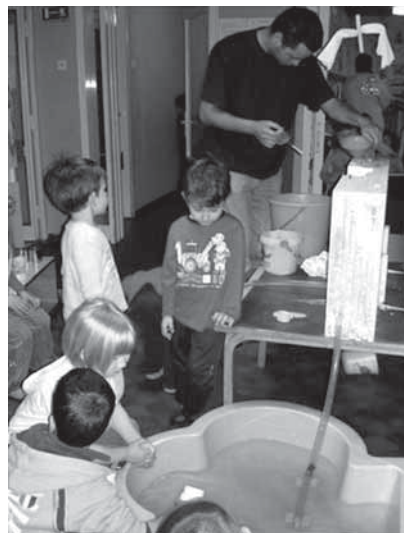
Naš sustav za pročišćavanje otpadnih voda
