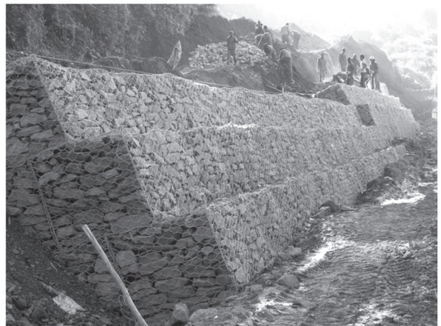
Slika 5. Slaganje gabionskoga obložnoga zida
