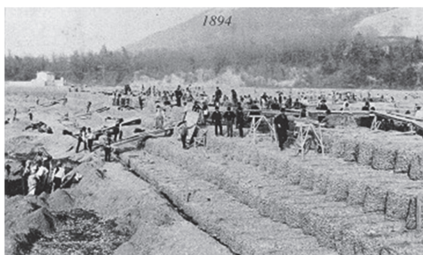
Slika 3. Vrećasti gabioni u Casalecchio di Reno Fig. 3 Bag gabions in Casalecchio di Reno
