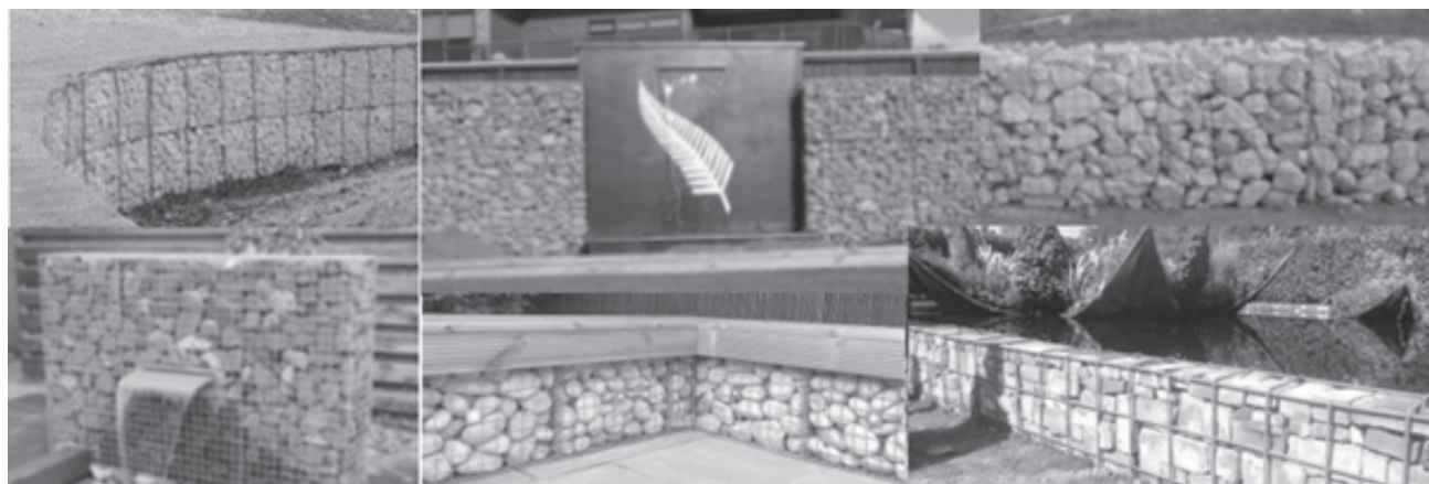
Slika 6. Primjeri primjene gabiona u uređenju okoliša
