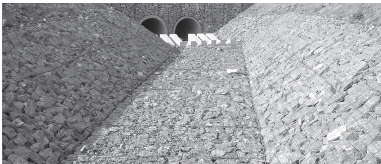
Slika 4. Uređenje vodenih tokova gabionima
