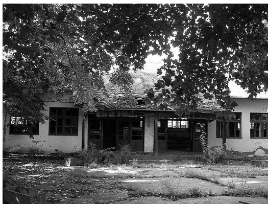
sl.5. Pogled na bočni dio desnog krila zgrade.
