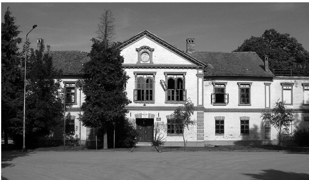
sl.1. Pogled na pročelje zgrade u Kneževu.
