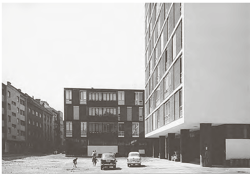
← Glavno pročelje stambenog nebodera u Laginjinoj ulici, Zagreb, arhitekt Ivan Vitić, 2004. ( http://domi-dizajn.jutarnji.hr/wp-content/uploads/2014/05/vitic6.jpg )
