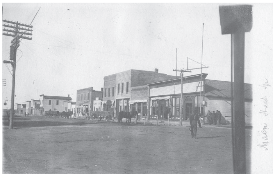
Slika 6: Spalding, glavna ulica
