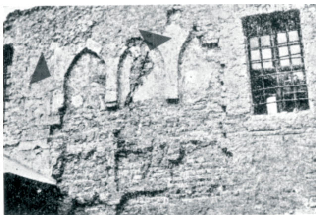
Sl. 10 Južno pročelje broda - stanje prigodom radova 1969.-1970.: u srednjoj se niši vidi zazidani gotički prozor (preuzeto iz: Lovrenčević, Medar 1977: 54)
