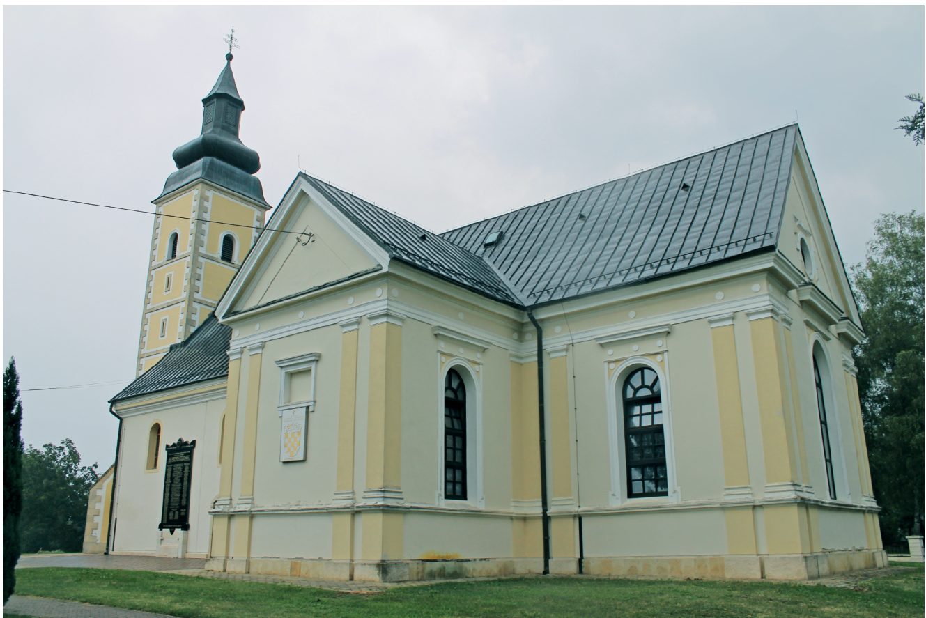
Sl. 2 Župna crkva Sv. Ivana Krstitelja u Žabnu, pogled od jugoistoka (foto: T. Tkalčec, 2016.) Fig. 2 St. John the Baptist Parish Church in Žabno, southeast view (photo: T. Tkalčec, 2016)
