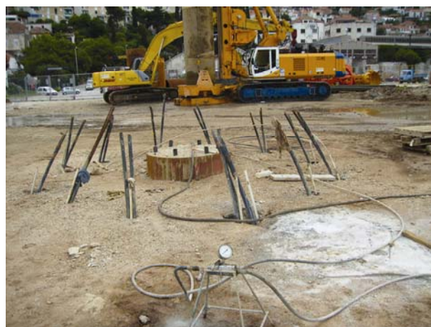
Slika 8. Geotehnička sidra u fazi injektiranja sidrišne dionice
