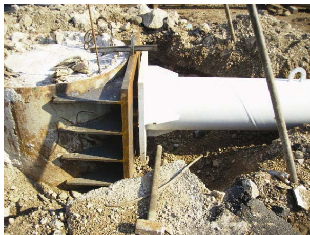
Slika 12. Detalj montaže čelične cijevi za razupiranje
