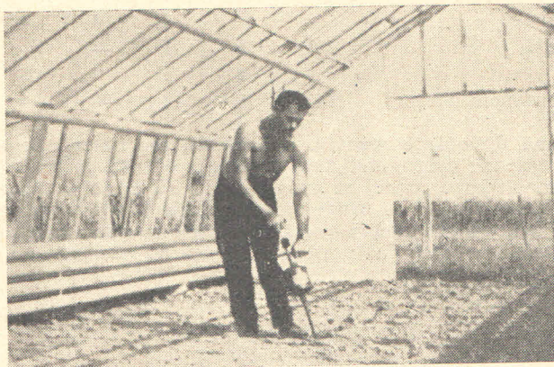
Kemijska sterilizacija zemlje ručnim injektorom u stakleniku
