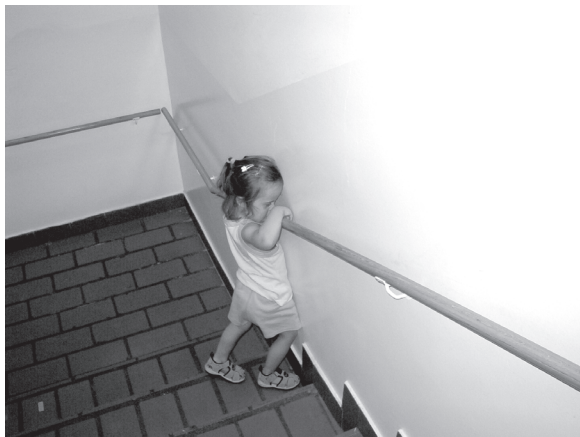
Uz stube koje vode do blagovaonice postavljeni su rukohvati kako bi se djeca mogla kretati samostalno
