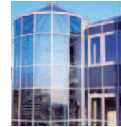
Čelične konstrukcije pročelja
