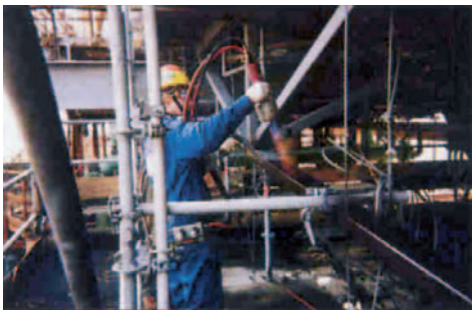
SLIKA 6. Vruće prskanje konstrukcije čeličnog mosta 9
