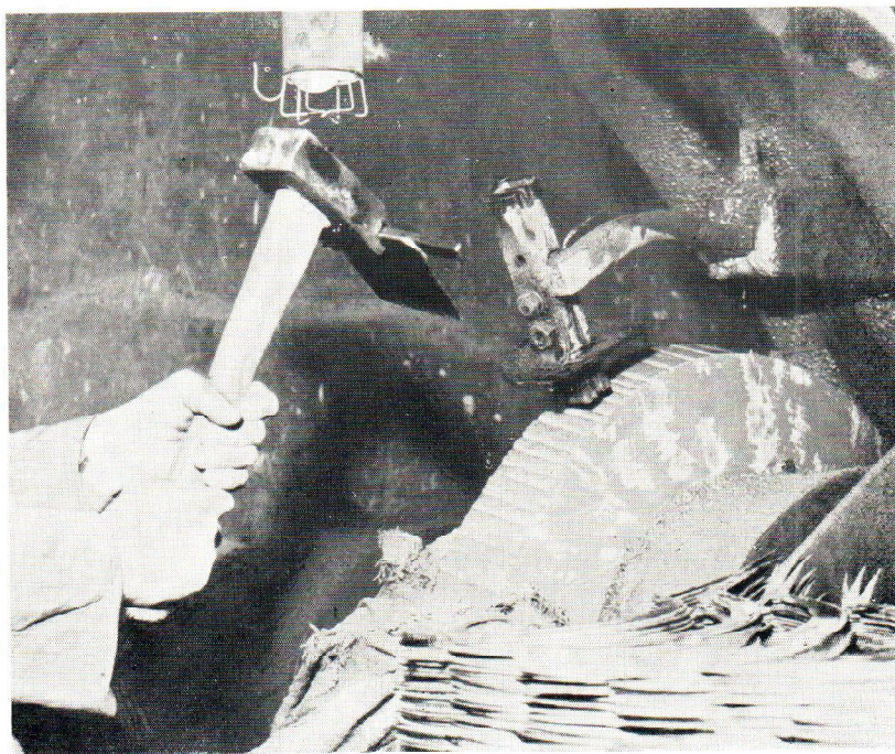
Sl. 2. Usijecanje brazdi na brusne površine kola
