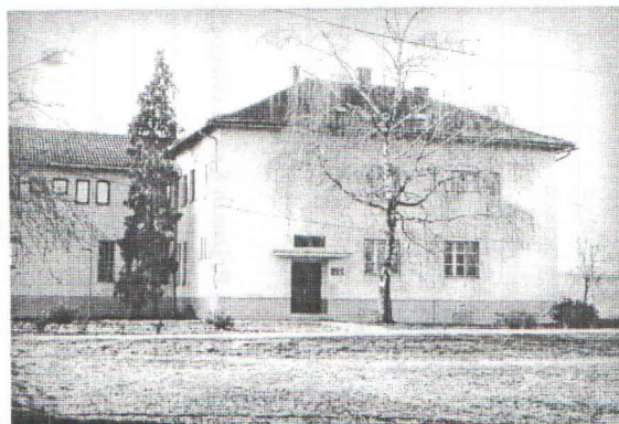
Zgrada Zavoda za strne žitarice u Botincu (foto dr. B. Palaveršić)
