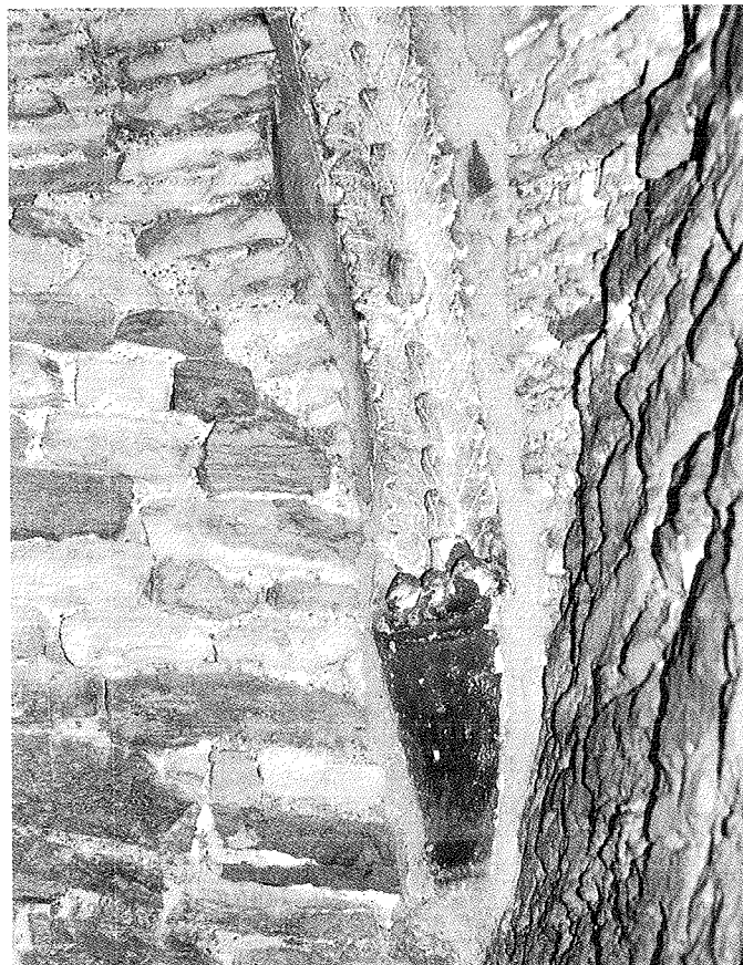
Fig. 7. Chapelle méridionale de Sainte-Marie Formosa - dét. de la guirlande de stuc de la voûte
