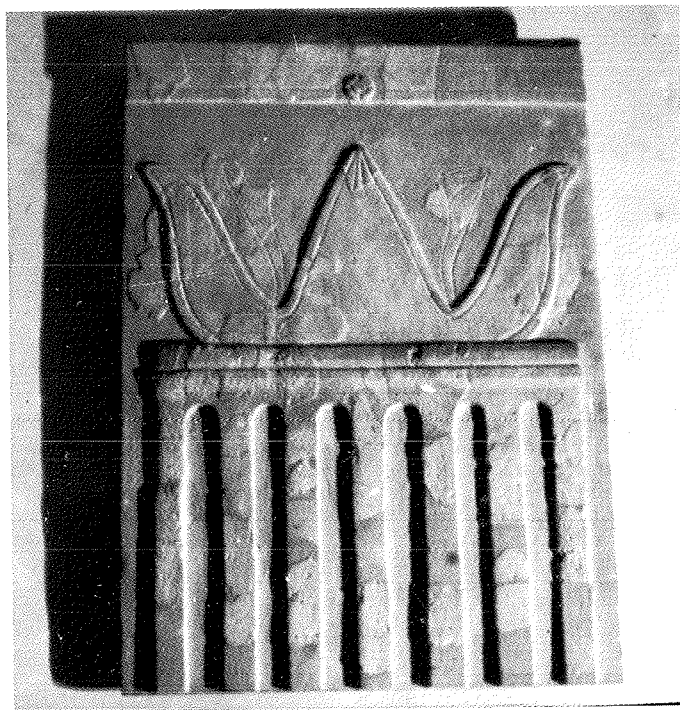
Fig. 12. Cathédrale Sainte-Marie-Majeure de Pula - revêtement en stuc d'un pilastre
