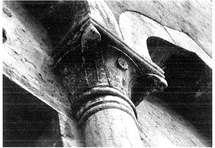
Fig. 12. Bale, palazzo Soardo-Bembo, capitello centrale della quadrifora superiore
