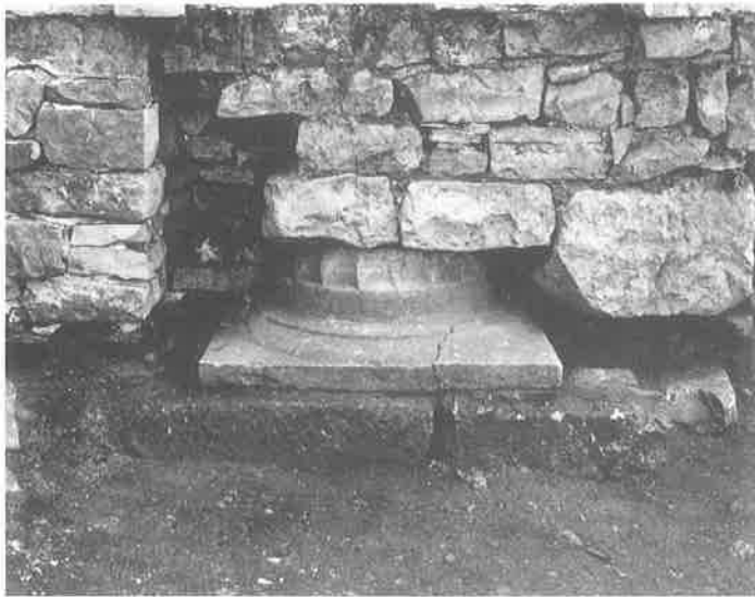
Fig. 2. Base de l'église ancienne (colonnade sud), prise sous le mur sud de l'église baroque.
