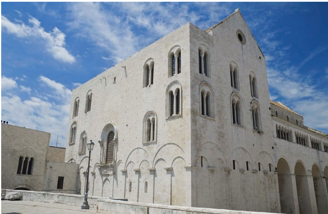
Fig. 28. Bari, basilica di S. Nicola, facciata orientale.
