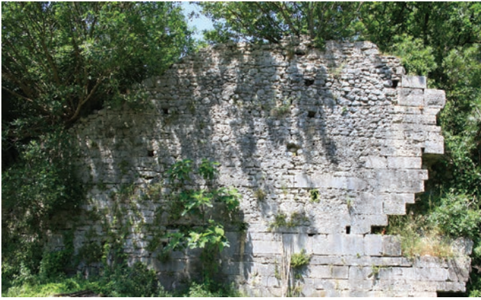
Fig. 3 Ponte Latrone (Capriati a Volturmo, CE), spalla orientale del ponte con restauri medioevali.
