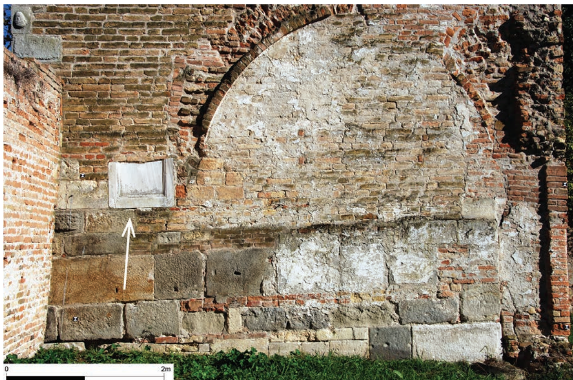
Fig. 3. Badia Polesine (Ro), Santa Maria della Vangadizza, parte basale del campanile con elementi di reimpiego.
