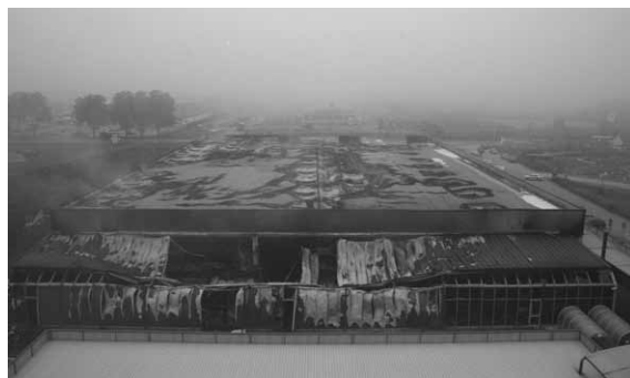
Slika 1. Tragovi požara na vanjskom dijelu objekta Figure 1. Traces of fire on the exterior of the building
