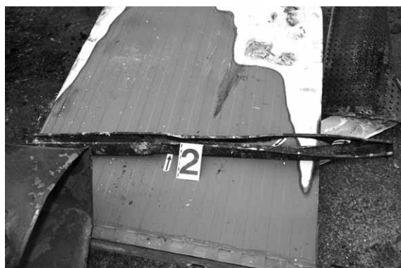
Slika 4. Tragovi termičkih oštećenja na kućištu svjetiljke
