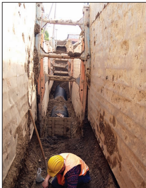
Slika 2. Iskop za kanalizacijski kolektor s mjestom nalaza (6. 10. 2005, Arhiva Konzervatorskog odjela Varaždin).
