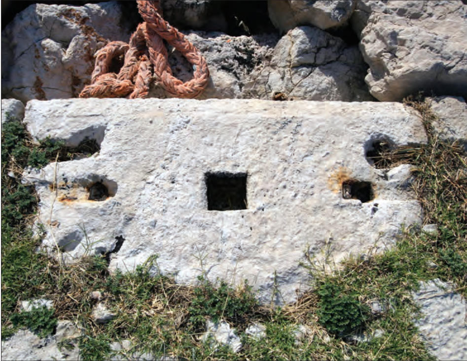
Slika 16. Detalj kamenih blokova s utorima za transport
