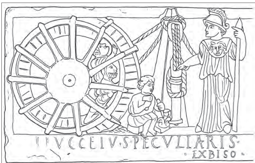
Slika 15c. Crtež rimskog reljefa dizalice na "ljudski pogon" (izvor: Jean-Pierre Adam, La construction romaine, matériaux et techniques . Paris: A. et J. Picard: Grands manuels Picard, 1989)
