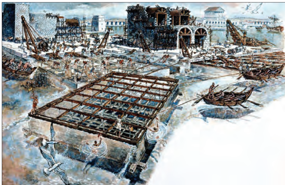
Slika 24. Prijedlog rekonstrukcije betoniranja gatova “rimskim betonom” pod morem (izvor: http://web.uvic.ca/~jpoleson/New%20Material/Caesarea%202005/Caesarea2005NGeog.jpg )
