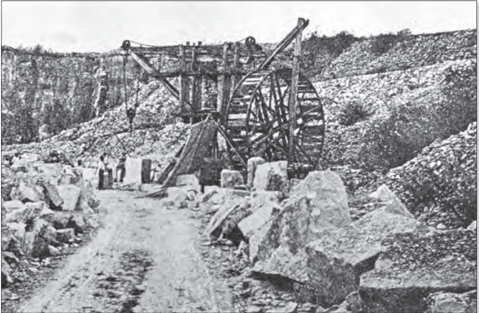
Slika 15a. Fotografija kamenoloma s dizalicom na “ljudski pogon” (izvor: Jean-Pierre Adam, La construction romaine, matériaux et techniques . Paris: A. et J. Picard: Grands manuels Picard, 1989)
