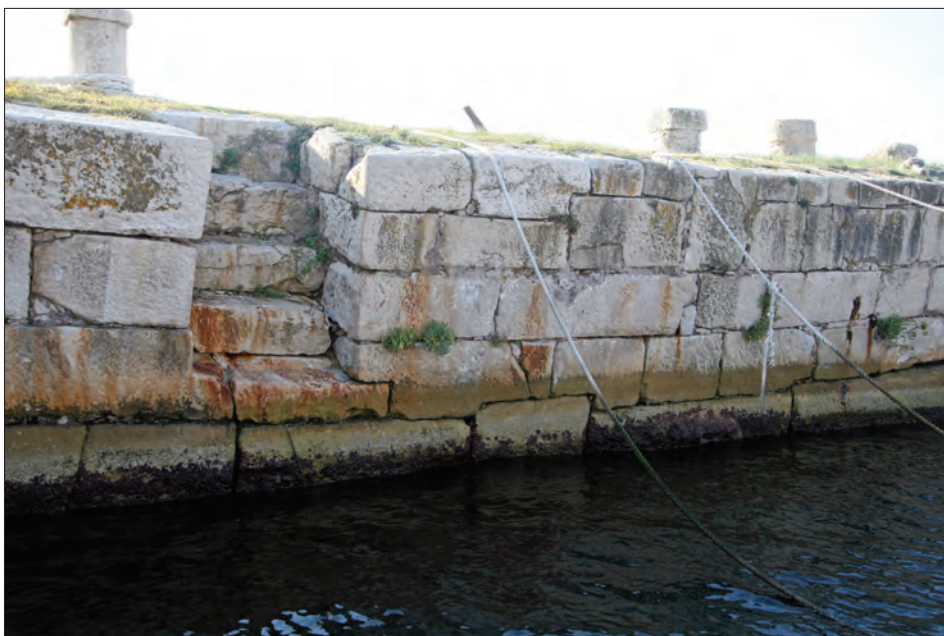
Slika 20. Tehnika zidanja Kaša s horizontalnim izmicanjem fuga
