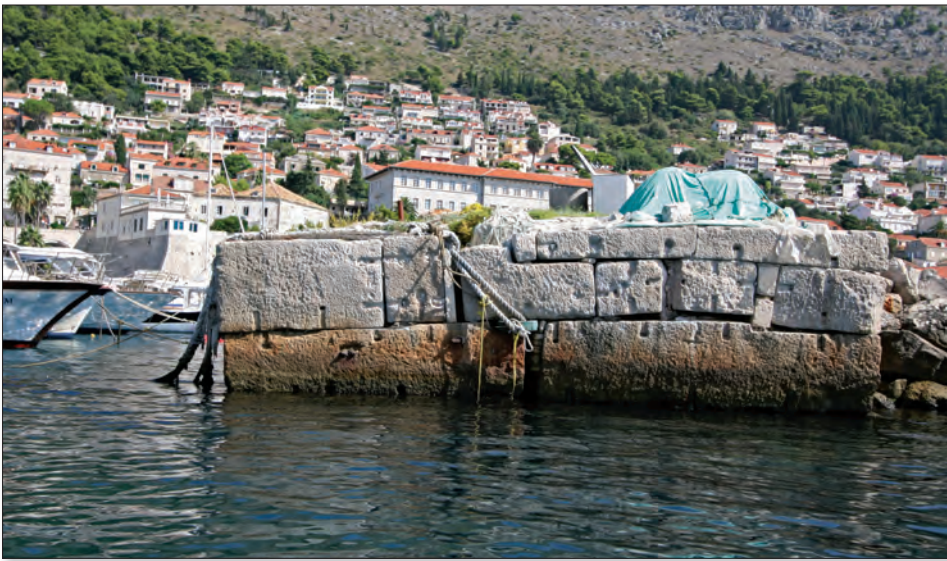
Slika 8. Fotografija južnog proćelja Kaša s ostacima tragova položaja spona
