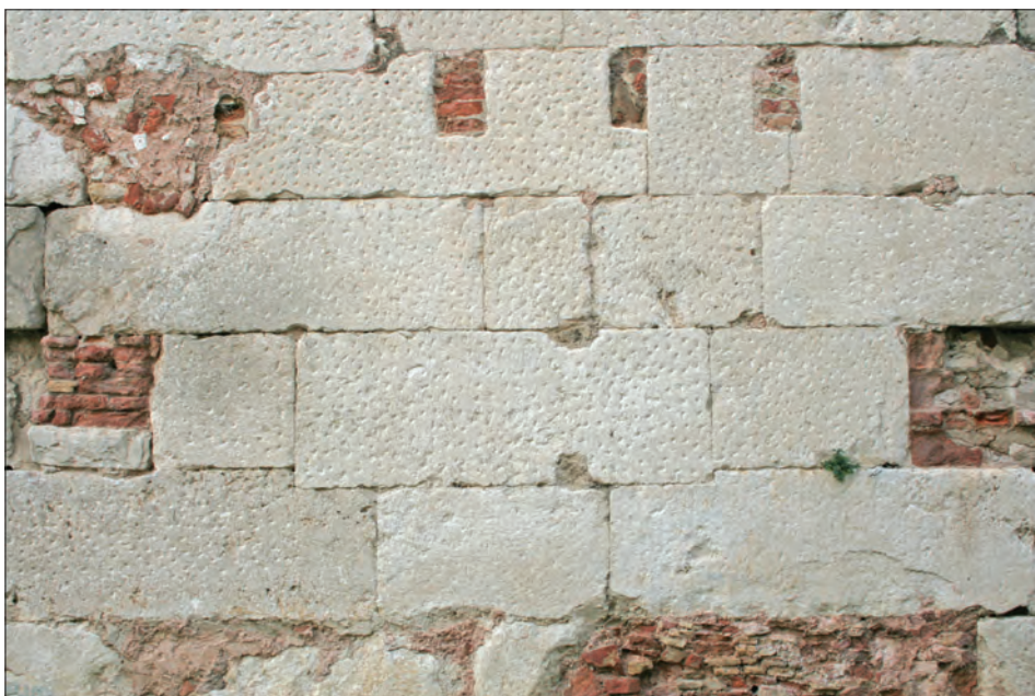
Slika 19. Dioklecijanova palača, Split, tehnika zidanja s izmicanjem horizontalnih fuga
