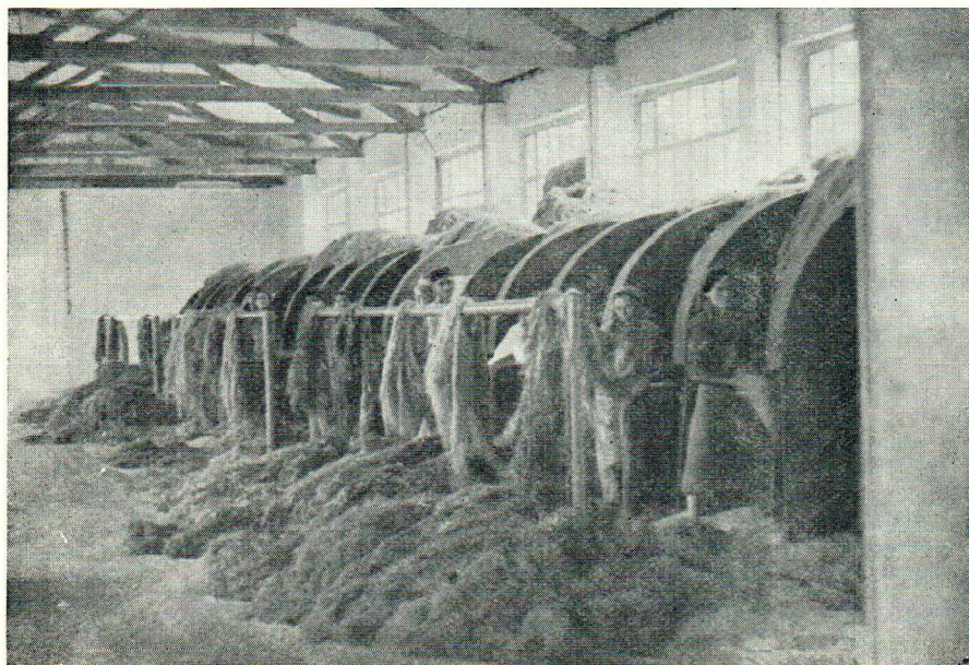
Sl. 4. »Grebanje« kudelje. Kod toga se stvara fina kudeljna prašina. Lokalni otvor prašine je praktički nemoguće izvesti.
