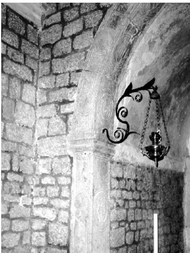
Sl. 22 Komrčar (Rab), crkva sv. Franje, unutrašnjost - sjeverni dio trijumfalnog luka apside (foto: dr. sc. D. Demonja).
