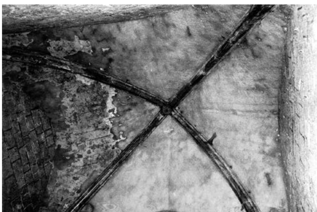
Sl. 26 Krk, crkva sv. Franje, unutrašnjost - rebra svoda apside (foto: dr. sc. D. Demonja).
