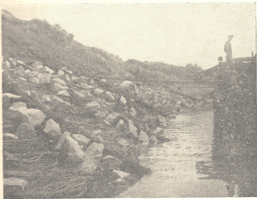
Sl. 2. Radovi na obaloutvrđi r. Save od sela Mahovo
