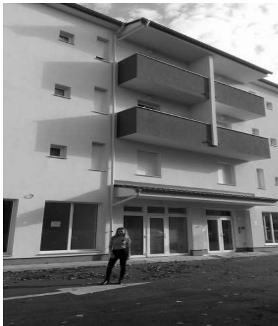
Slika 2. Stambeno-poslovna novoizgrađena zgrada u Pazinu
