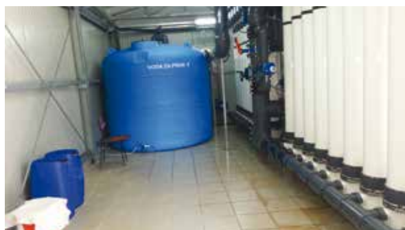
Slika 2b: Membranski proces ultrafiltracije
