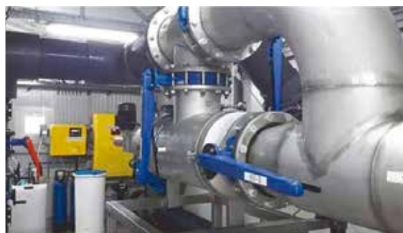
Slika 3: Uređaj za mikrofiltraciju i dezinfekciju vode na bazi procesa elektrolize otopine NaCl
