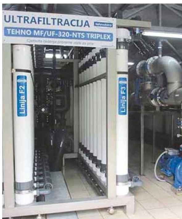
Slika 2a: Membranski proces ultrafiltracije
