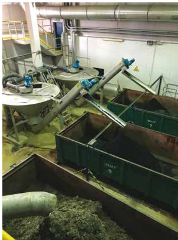
Slika 9: Obilazak UPOV-a: klasireri pijeska i izdvajanje krutog otpada s ulaznih mikrosita (snimio D. Nakić)
