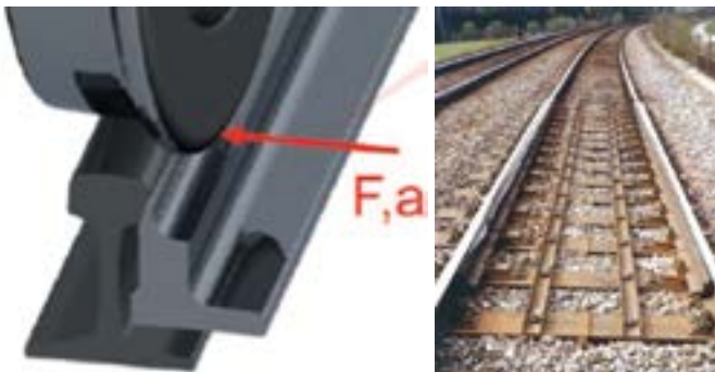
Slika 10.a i 10.b Tračnička dilatacijska naprava
