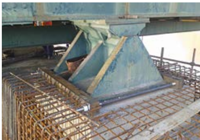
Slika 5. Okvir nepokretnog ležaja stupa S3
