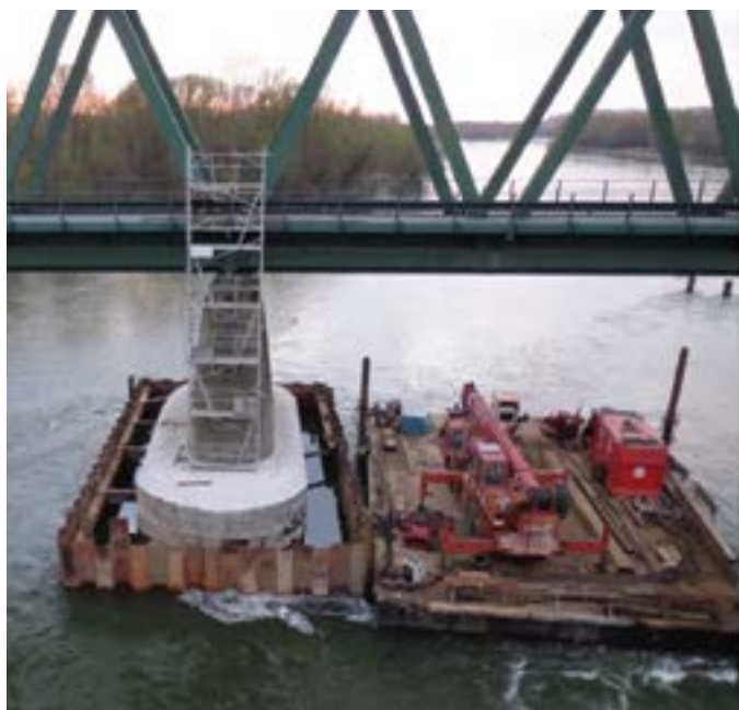
Slika 2. a) Pogled na zagat od čeličnog žmurja i b) radovi na ojačanju AB temeljne stope
