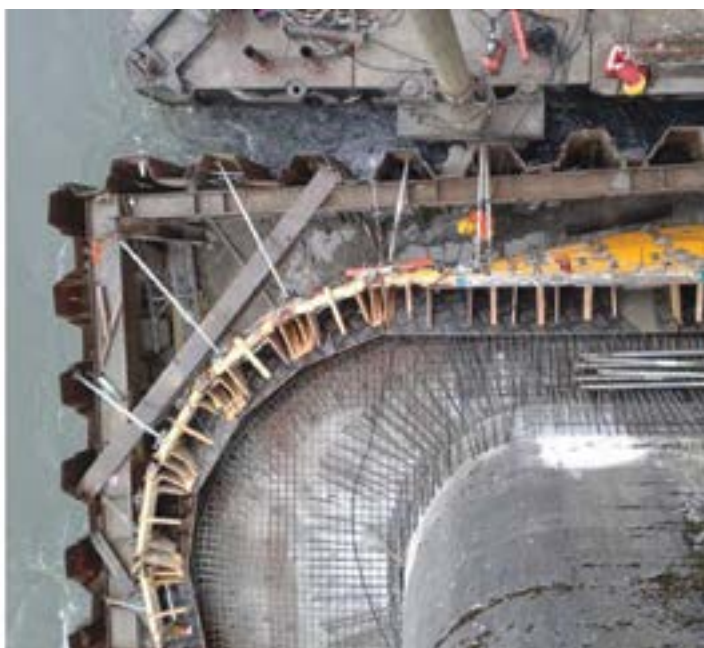
Slika 2. a) Pogled na zagat od čeličnog žmurja i b) radovi na ojačanju AB temeljne stope
