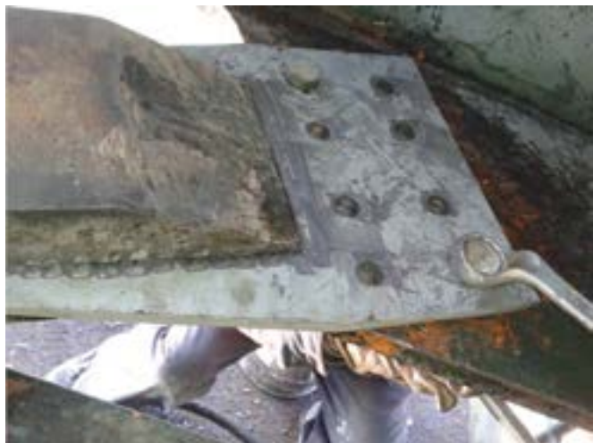
Slika 7. Novi čvorni lim s većim rupama za zakovice f 23 i priprema za zavarivanje čvora
