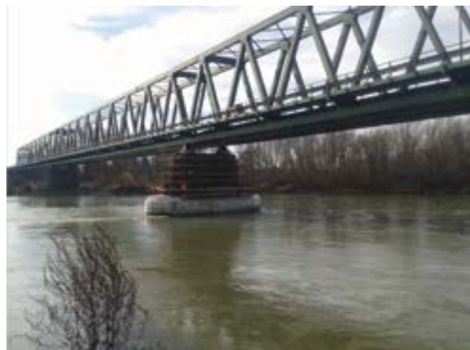
Slika 1. Pogled na most i stup S3 u rijeci Dravi
