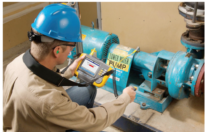
Slika – Mjerenje vibracija pumpe. Razumijevanje vibracija nam pomaže u predviđanju problema u radu i planiranju održavanja.
