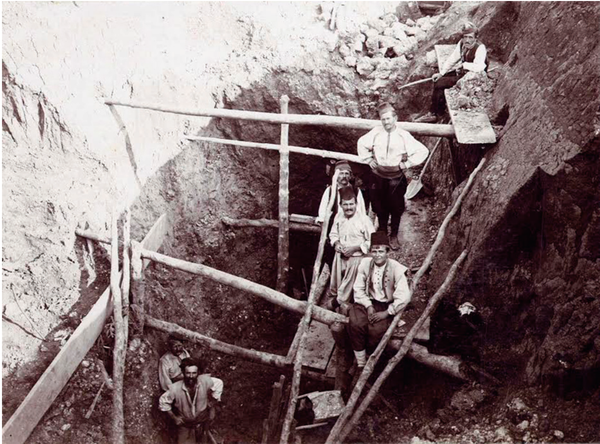
Slika 2. Iskopavanje začepljenih ponora kod Ivan Doca 1907. godine
