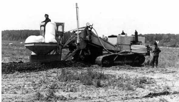
Slika 9: Ugradnja PVC drenažnih cijevi za podzemnu odvodnju
