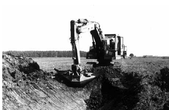
Slika 8: Iskop melioracijskog kanala za površinsku odvodnju
