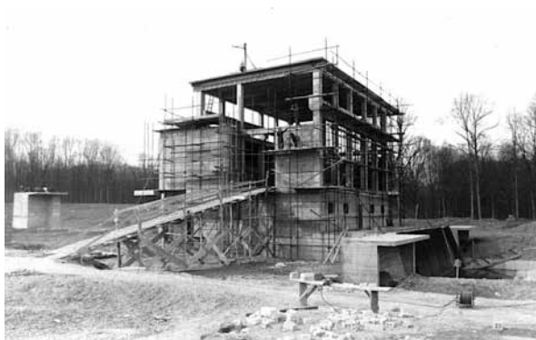
Slika 7: Izgradnja crpne stanice Konjuša u Gunji 1983. godine ( Q = 5,5 \text{ m}^3 \text{ s}^{-1} )
