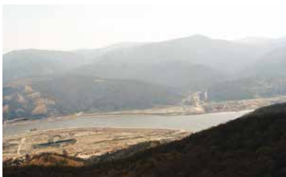
Slika 14. Pogled na građevnu jamu u Dunavu prije restauracije (izvor: File:Épül a nagymarosi vízlépcső. Fortepan. 19373.jpg - Wikimedia)
