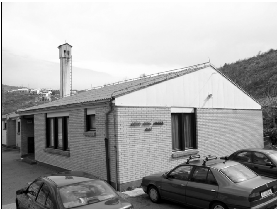
Sl. 1. Zgrada Dječjeg vrtića Travica u Senju (foto: Arhiv GMS)
