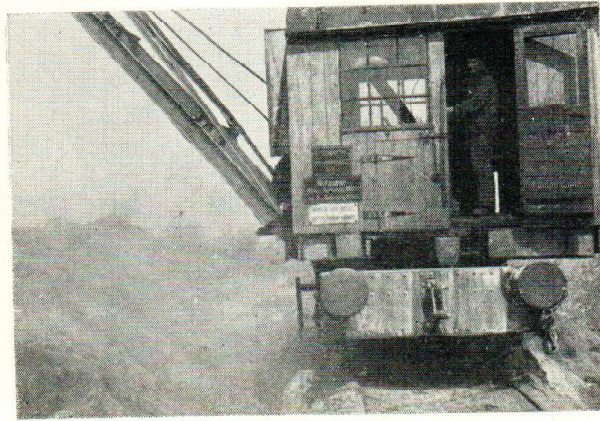
Foto 4. Die Halden, wo Gichtstaubmengen gelagert werden.
