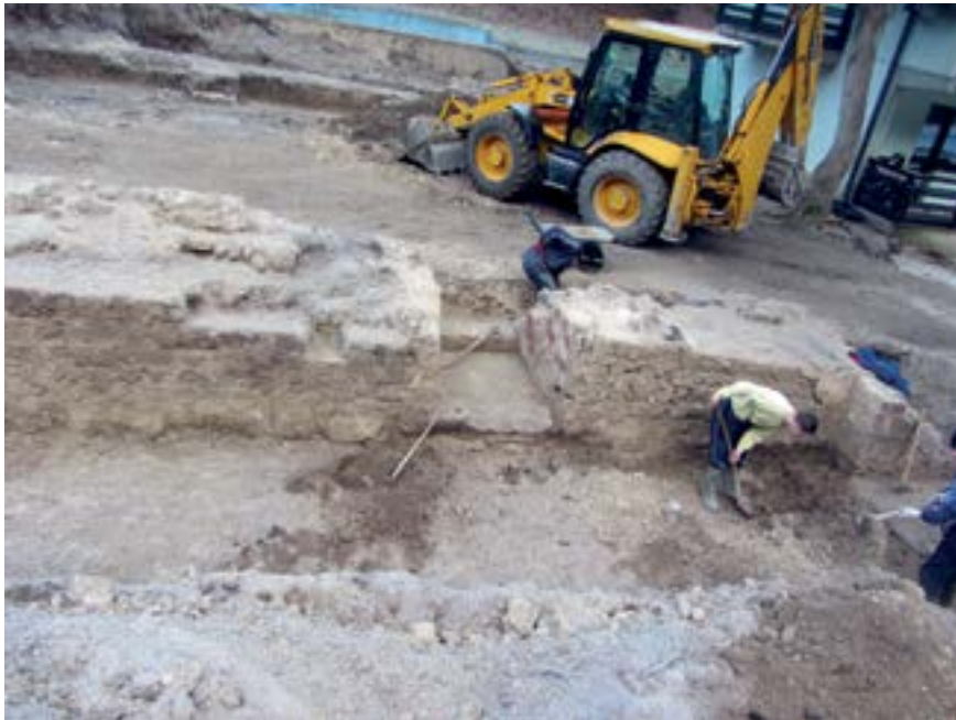
Sl. 11. Otkopavanje zida između sjeverne i srednje prostorije Fig. 11. Excavation of a wall between the north and central room
